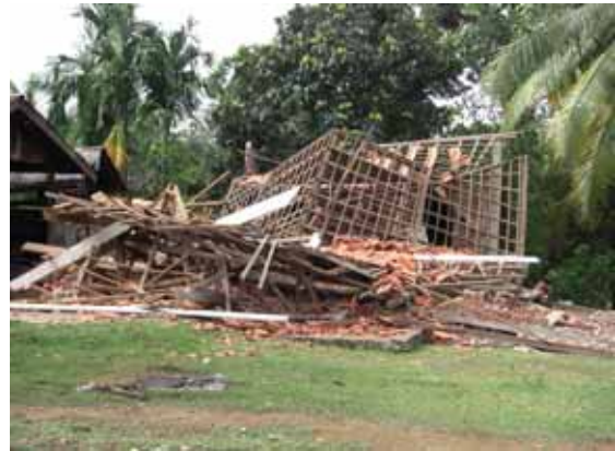
地震被害により倒壊した建築物
