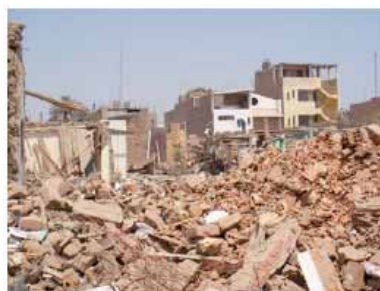
ピスコ市内の倒壊した建物
