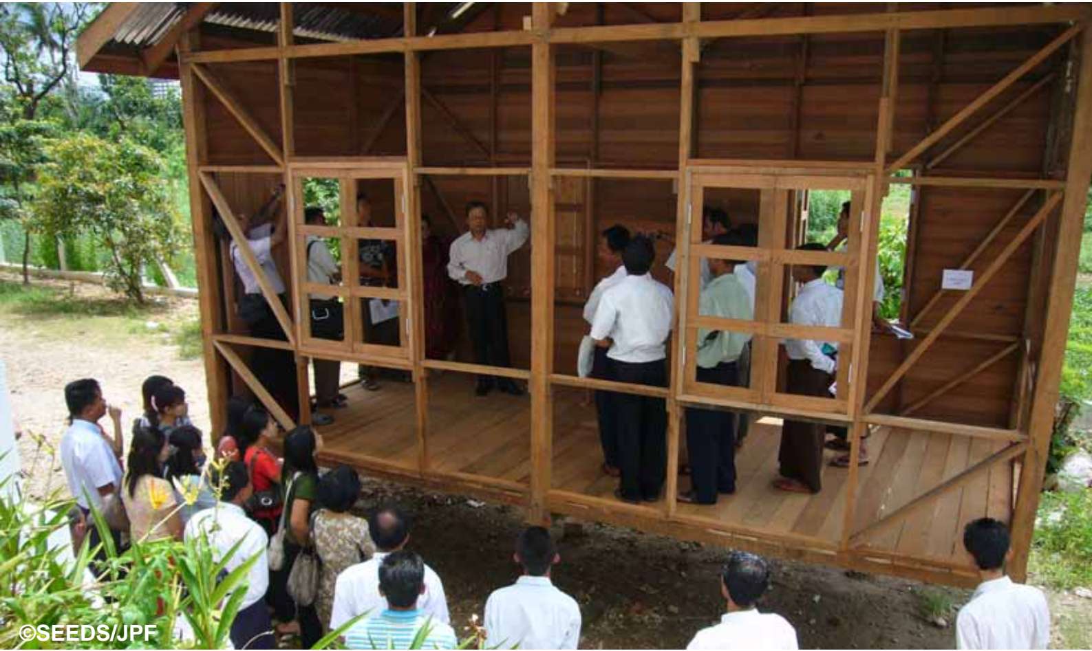
モデル住宅を使った地元大工に対する家屋補強の現地訓練 (ヤンゴン市内)
