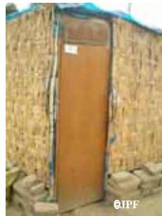
Estructura simple con esteras y puerta, y forro plástico para evitar ingreso de arena
