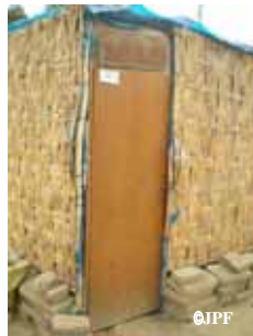
葦マット、防砂用ブルーシート、ドアの簡単なつくり
