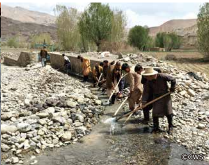
災害リスク削減のための灌漑水路の整備作業
