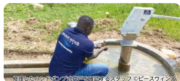
修理したハンドポンプ式井戸を確認するスタッフ ©ピースウィンズ
