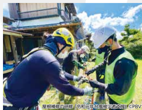
屋根補修の研修「令和元年台風被災者支援」©PBV
