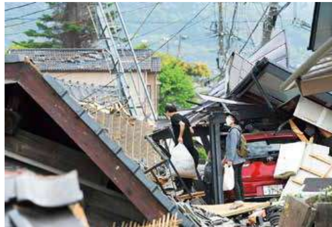
倒壊した住宅のがれきで埋め尽くされた道路＝2016年4月20日、益城町
