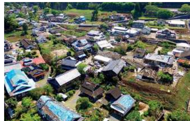
多くの建物が倒壊した西原村の布田地区＝2016年4月20日
