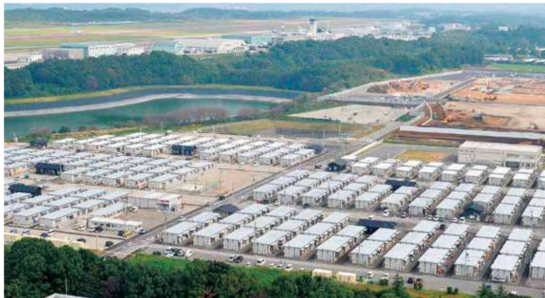
熊本県内最大規模の516戸が並ぶ応急仮設住宅「テクノ仮設団地」＝2016年10月
