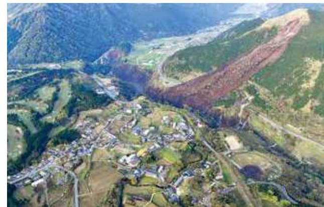
阿蘇大橋崩落＝2016年4月16日
