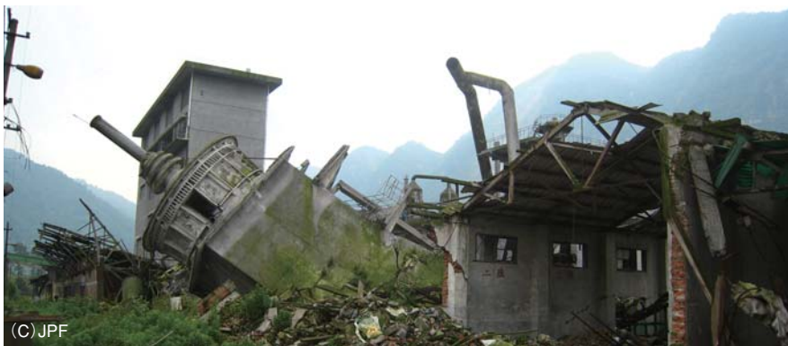
倒壊した化学工場
