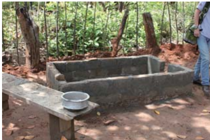
建設中のトイレ（ムラティブ県）
