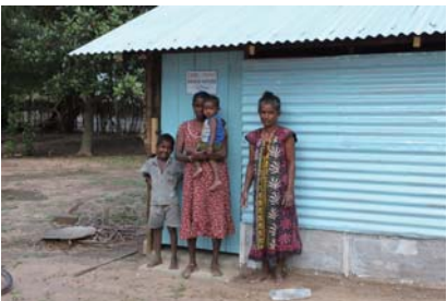
完成した仮設住宅（ムラティブ県）
