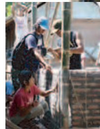
船渠シェルターの建設 ©JPF
