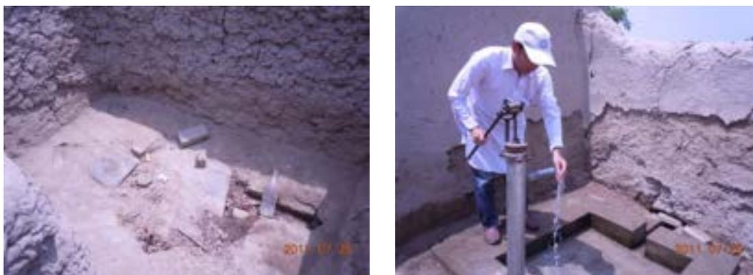
井戸の設置にかかる問題の1つとして、排水溝の問題が挙げられる。NICCOによれば、排水を住居に隣接する畑に導くよう排水溝を設置するのが基本としているとのことであるが、住民の中には住居に隣接する畑を持たない者もあり、そのような場合は樹木に導くなどして可能な限り排水が収集されるような措置を施している。しかしながら、このような場合、有機物を多く含んだ排水の滞留を防ぐことは難しく、衛生面での課題が残る状況となっている。
