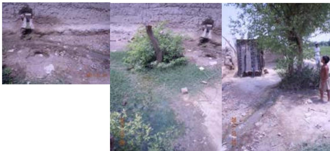
(注) 民家に設置された井戸の排水溝が囲い塀から外へ出ている（左）。この家は畑を持たないため、代わりに近くの樹木に排水を導くものの、完全には吸収されない（中、右）。
