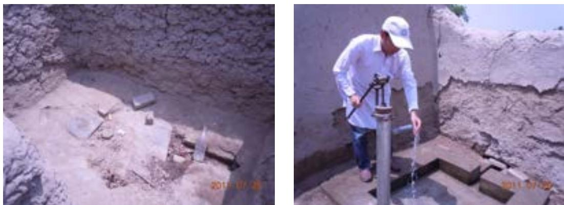
井戸の設置にかかる問題の1つとして、排水溝の問題が挙げられる。NICCOによれば、排水を住居に隣接する畑に導くよう排水溝を設置するのを基本としているとのことであるが、住民の中には住居に隣接する畑を持たない者もおり、そのような場合は樹木に導くなどして可能な限り排水が収集されるような措置を施している。しかしながら、このような場合、有機物を多く含んだ排水の滞留を防ぐことは難しく、衛生面での課題が残る状況となっている。
