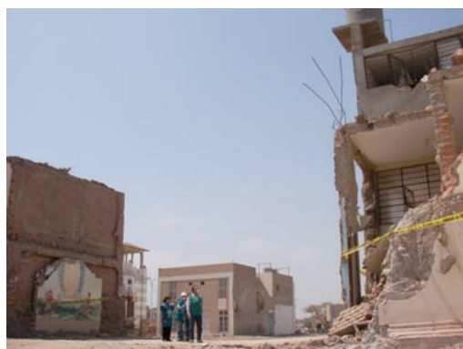
教会が全壊し、多くの死者が出た
