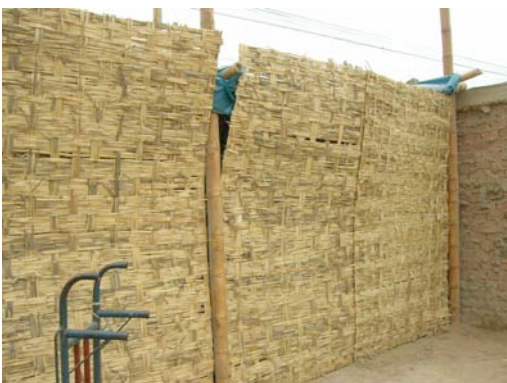
エステラ仮設住居で風雨をしのぐ
