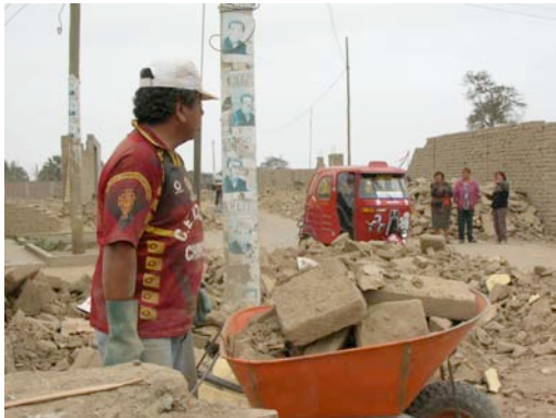
瓦礫撤去を行う被災者
