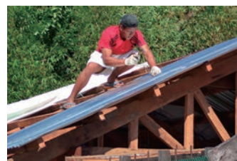
配布したトタン板、金槌、傘釘を使い、 屋根を修理している様子
