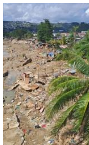
被害が大きかったタリサイ市（セブ市に隣接）。多くの家屋が全壊し、瓦礫と土砂が堆積している (C) JADE
