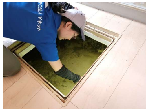
浸水した家屋に送風機を設置／千葉県佐倉市 2026.08.16 ©Vネット
