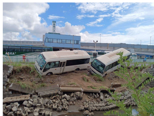
豪雨で崩れた道路／千葉県千葉市／2026.08.14©JPF
