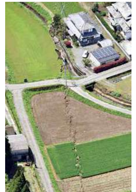
益城町内で地表に出現した断層 = 2016年4月17日
