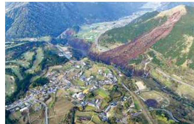
阿蘇大橋崩落 = 2016年4月16日
