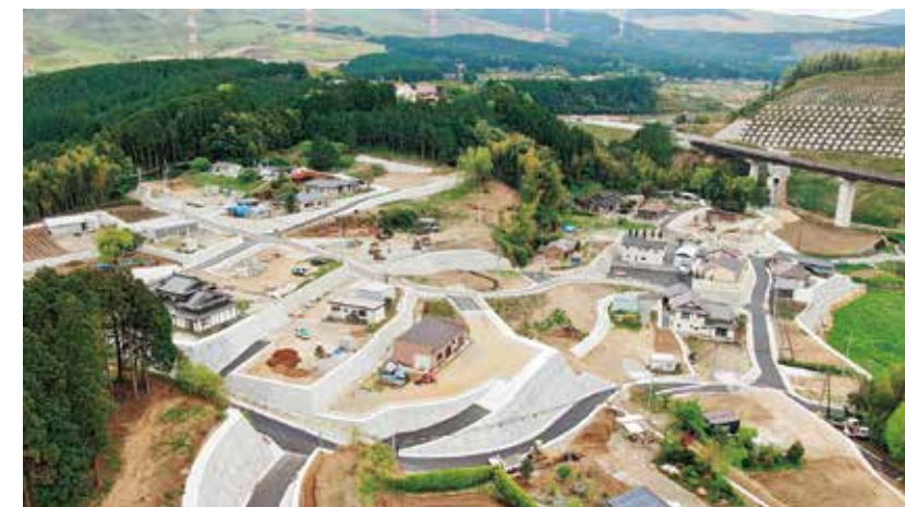
《集落再生》熊本地震から5年を経て、復旧工事が完了した西原村の大切 畑地区=2021年4月
