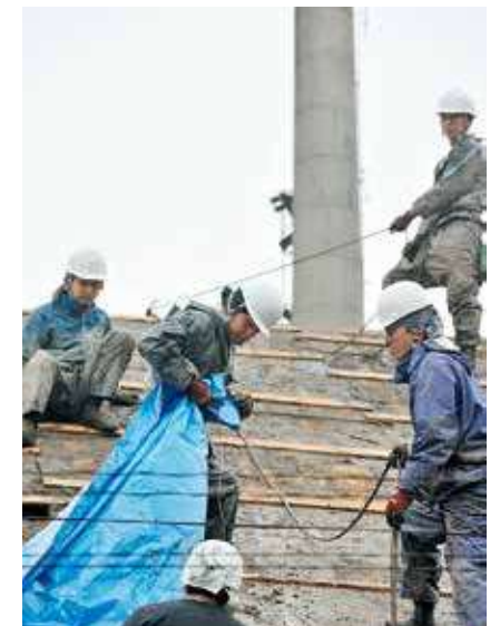
地震で破損した屋根瓦を撤去し、ブルーシートをかぶせるボランティア =2016年4月25日
