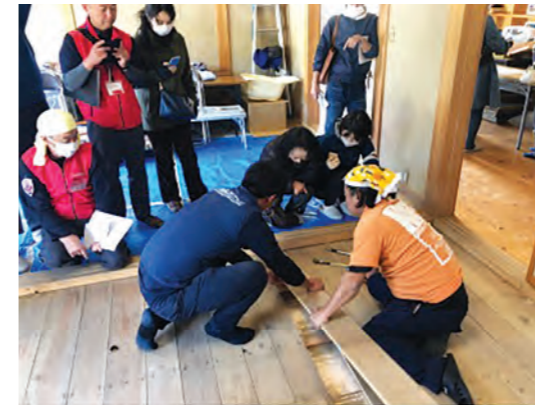
家屋保全講習会での床板剥がしの様子 ©PBV
