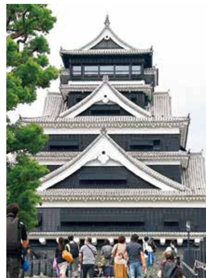
復旧が完了し、約5年ぶりに一般公開された熊本城天守閣＝2021年6月
