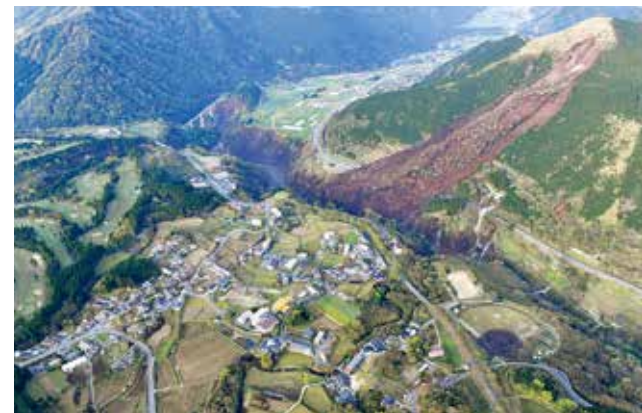
阿蘇大橋崩落=2016年4月16日
