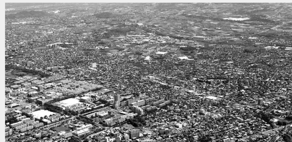
多くの屋根がブルーシートに覆われ青く染まった熊本市内
