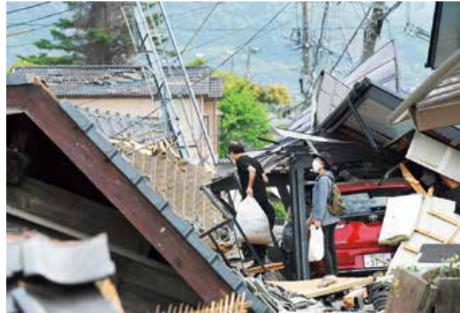
倒壊した住宅のがれきりで埋め尽くされた道路=2016年4月20日、益城町
