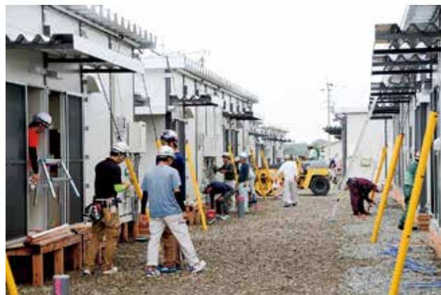
急ピッチで建設が進む応急仮設住宅（西原村） = 2016年6月
