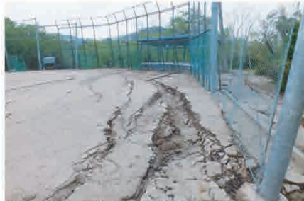
地面に大きなひびが入った町民グラウンド
